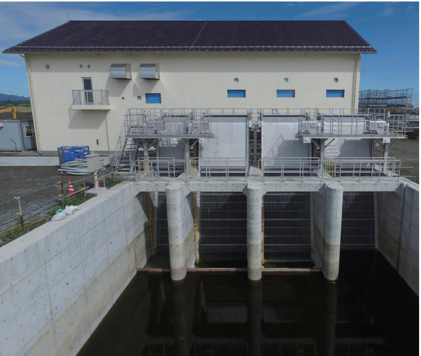
開成工業は、水門設備の建設会社であり、水門に用いる鋼構造物のメーカーである。写真は、福島県の排水機場に設置された除塵機。幅3~4メートル、高さ6~7メートルの装置を4連並べて、ポンプ吸い上げ前の水からゴミを取り除き、排水ポンプが詰まるのを防ぐ。撮影にはドローンを使用。
